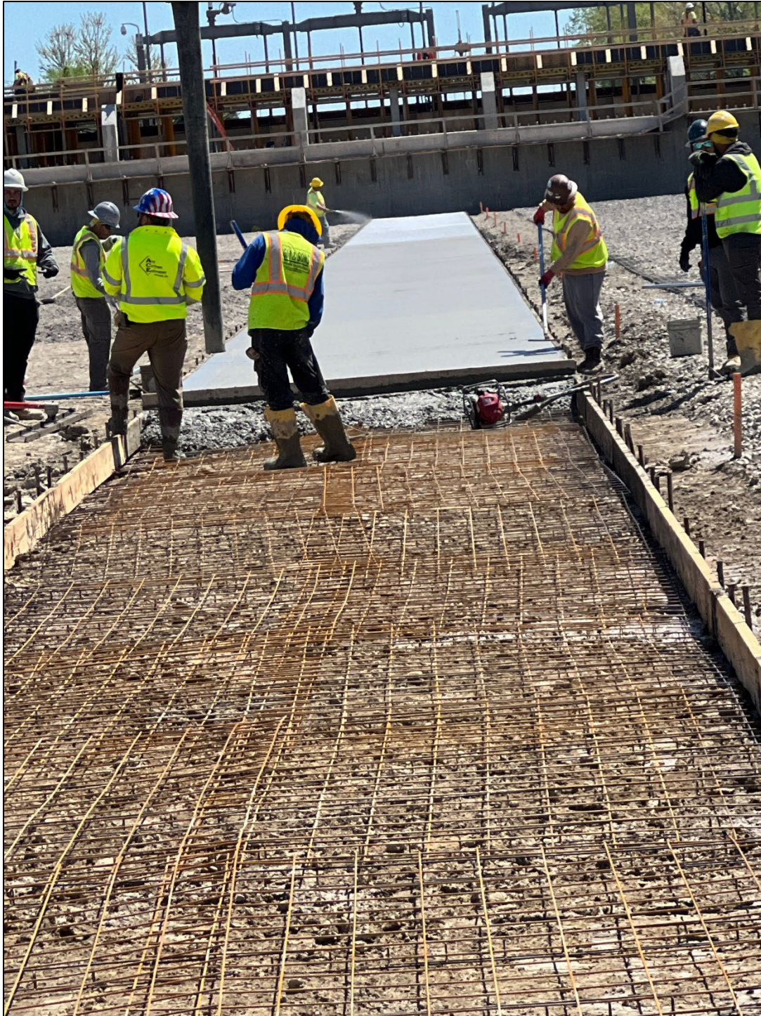
Figure 23 – Canal Bottom Center Spillway Pour
